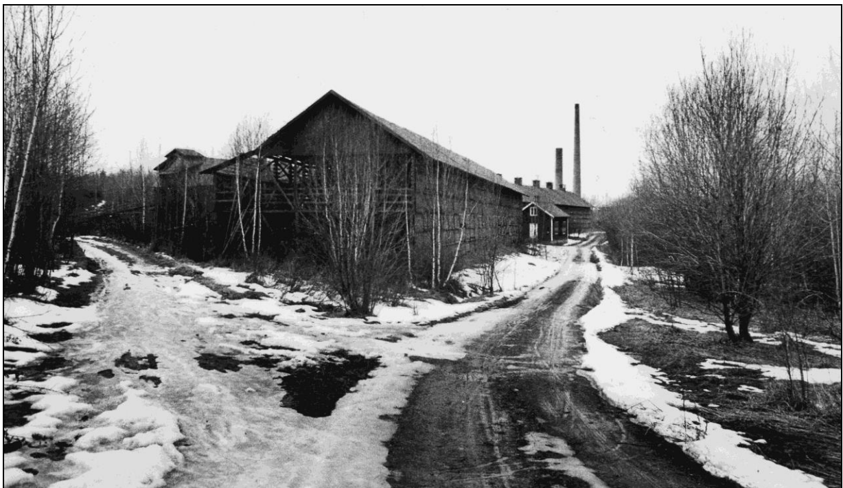
T Toresund, Sunby 1:1 år 1977. Sundby tegelbruk med torklador i förgrunden. 52 Skorstenar i bakgrunden, uppfart till pressen t.v. Tegelbruket nedlagt 1967.
