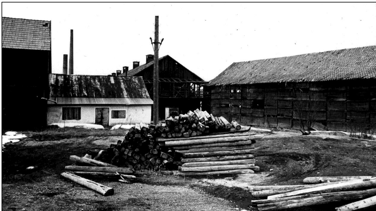
T 53 Toresund, Sundby 1:1 år 1977. Sundby tegelbruk från SO.
